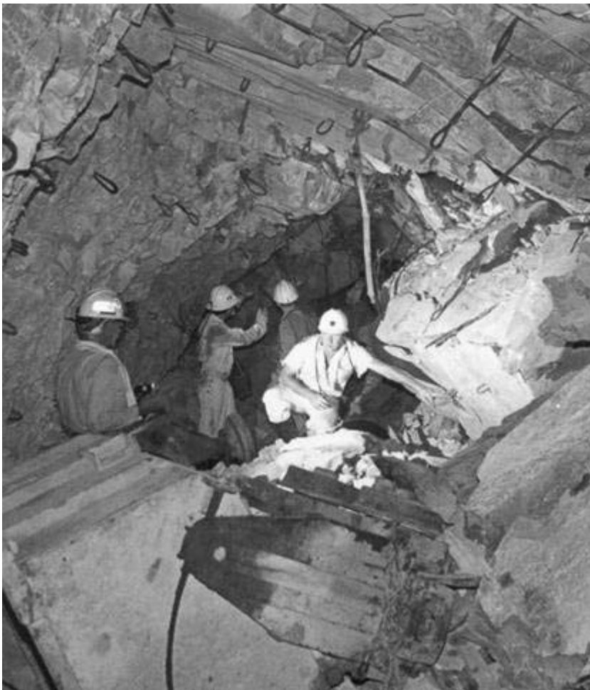
Obr. 7 Závaz důlní chodby následkem otřesu v jednom ze zlatých dolů v jižní Africe (snímek získán díky R. Grobbelaarovi).
