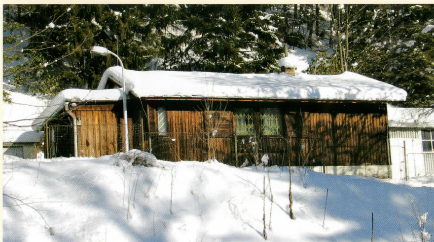
Dřevěný pavilon finského typu na stanici Kašperské Hory. Jsou zde umístěna původní analogová registrační zařízení ze šedesátých a sedmdesátých let. Foto: Petr Jedlička
