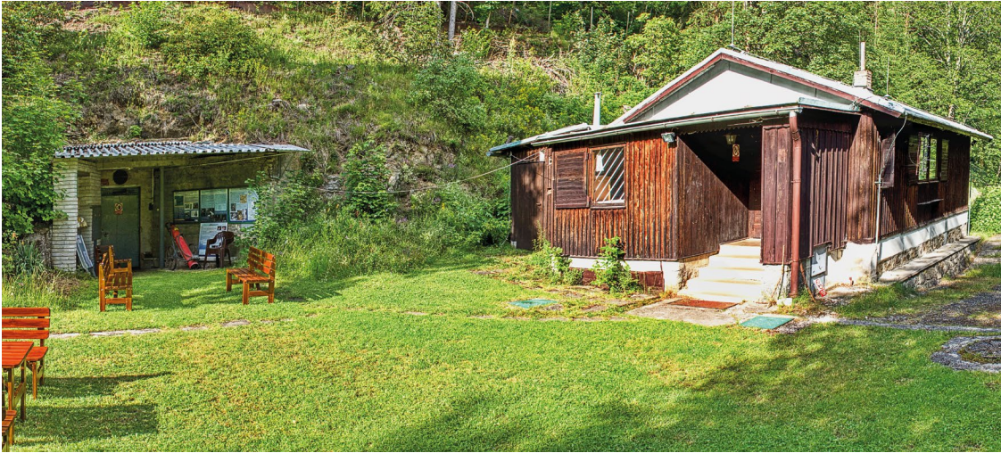
Obr. 7 Seismická stanice Kašperské Hory. Vlevo vstup do štol Kristýna, ve které jsou umístěny měřicí přístroje. Vpravo stará, nyní již nepoužívaná provozní budova, kde se nyní nachází Muzeum seismometrie. Stav z léta 2020. Foto: autor
