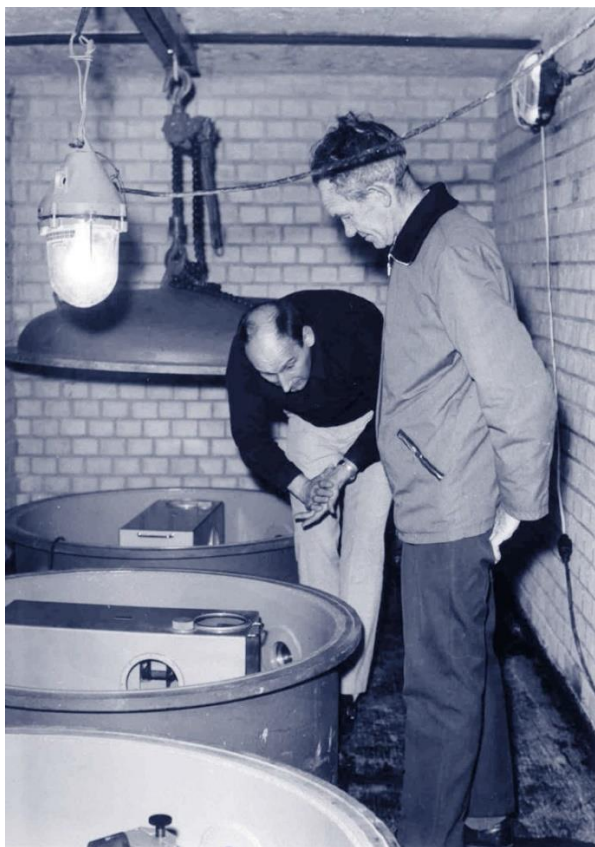
Axel Plešinger (vlevo) při údržbě širokopásmového snímače ve štole Kristýna, vpravo Bohumil Bartizal, technik a dlouholetý správce observatoře kašperské Hory v 60. a 70. letech minulého století. FOTO: Geofyzikální ústav AV ČR
