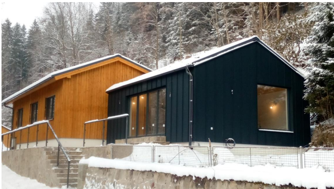
Nově zrekonstruované pavilony observatoře Kašperské Hory (únor 2023). Expozice Muzea seismometrie se nachází v části dřevěného pavilonu, pavilon s antracitovým oplechovaným pláštěm slouží jako přednáškový sál. Vstup do štoly Kristýna se nachází vpravo za dřevěným pavilonem. FOTO: Geofyzikální ústav AV ČR
